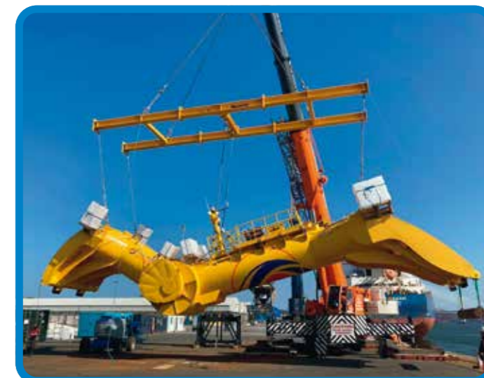
Bastidor elevación Mocean Energy
